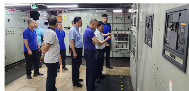
集团领导班子赴珠海免税商场配电房进行安全检查
